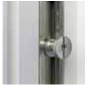
Galet anti-décrochement réglable en compression
